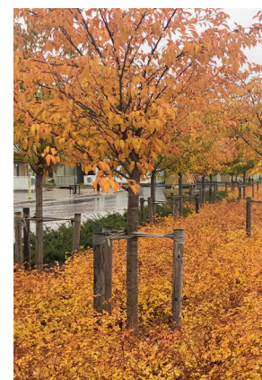
Förankrade trädstöd vid Allétorget.
