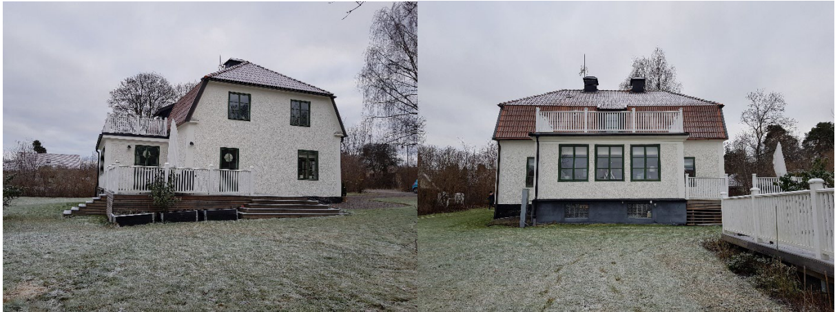
Bilder på baksidan och högra sidan av det befintliga enbostadshuset.
