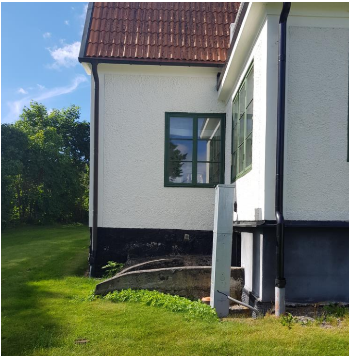
Figur 7. Figuren visar stuprör som leds ned i marken från befintlig byggnad. Foto: Sweco.
