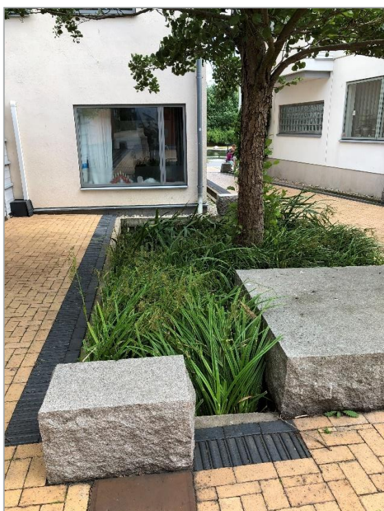
Figur 4:3. Behandling av dagvatten i regnbädd i Malmö (foto: Norconsult).
