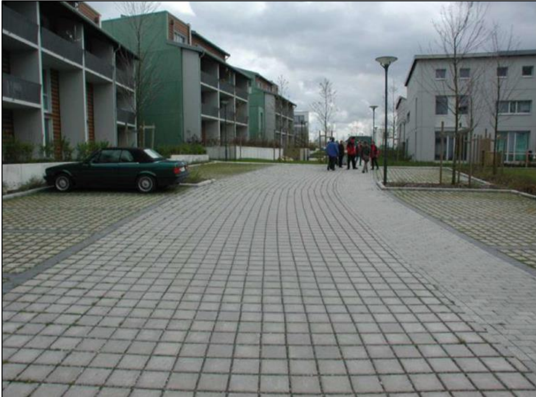
Figur 4:5. Parkering och gata med genomsläpplig beläggning (Foto: Norconsult).
