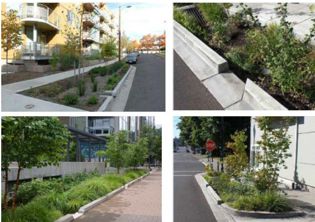
Figur 11 Bilder på nedsänkta växtbäddar på gatumiljö. Övergången mellan gångbana och växtbädd kan skapas utan kantsten och att kantsten med släpp anläggs i övergången mellan väg och växtbädd (Källa: Sweco).
