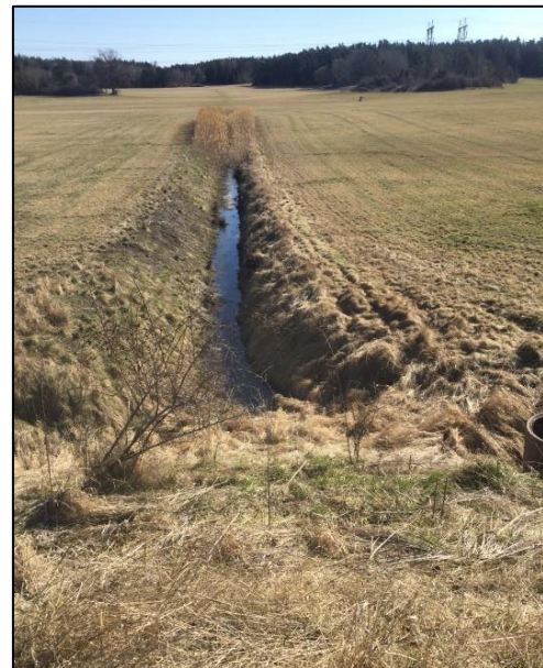
Figur 7. Slänt mot dike, vy mot öster. Källa: Tyréns Sverige AB
