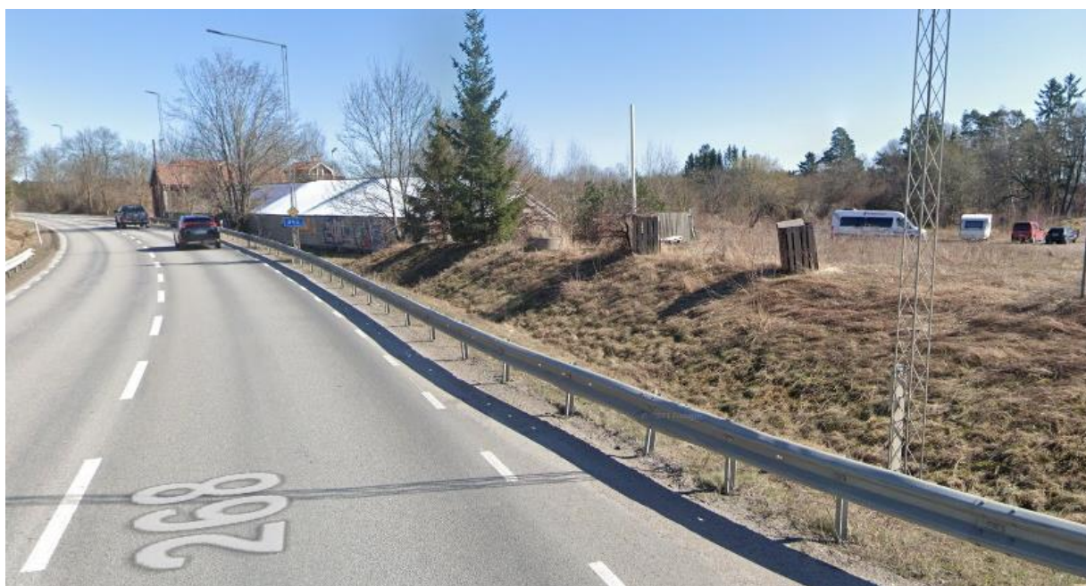
Figur 7. Vallentunavägen i norrgående riktning, planområdet ligger till höger om avåkningsskydd. Bild från google maps street view [11].
