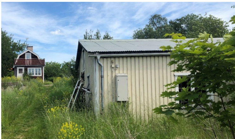
Figur 67. Verkstadsbyggnad/ Garage (1900-tal).
