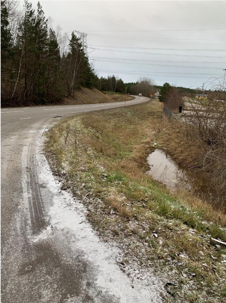
Figur 11: Korsningen väg 872 - Torslundavägen, tittandes norrut.
