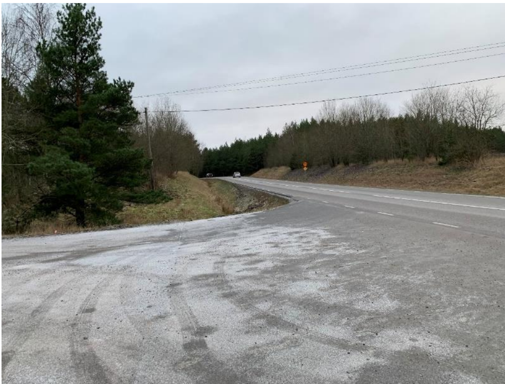
Figur 12: Korsningen väg 872 - Torslundavägen, tittandes söderut.
